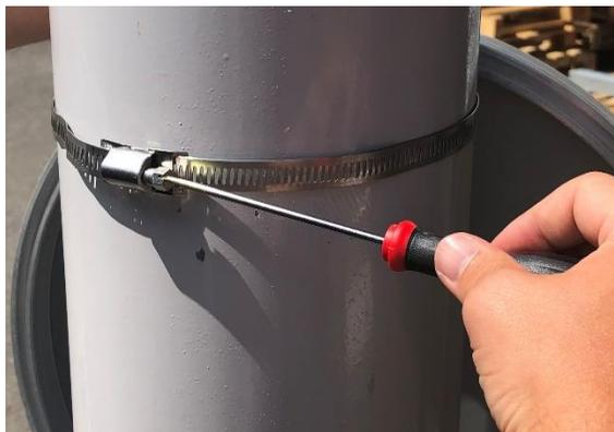
Vissez la vis de la cage à vis pour faire coulisser la bande métallique et obtenir le serrage nécessaire
