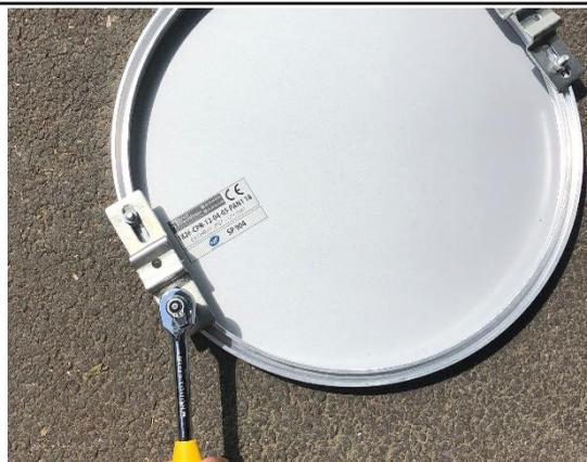
Fixez la bride sur le rail du panneau à l'aide des vis à tête marteau et des écrous. Serrez à l'aide de la clé à pipe.
