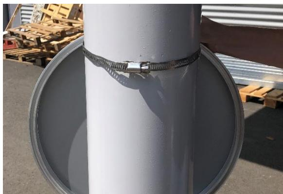
Faites le tour du poteau avec la bande métallique et repassez l'extrémité dans la cage à vis
