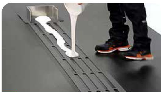
3 Verser la résine devant le godet Easy-Lisse® et sur la bande
